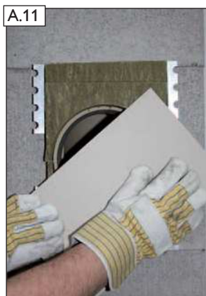
... A s pomocou vyrezávacej šablóny zatlačte/zarovnajzte čelnú dosku s rovinou komínovej tvárnice
