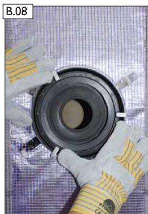
Vonkajší adaptér s naneseným lubrikantom na jeho okraj osadíte do omietkového kruhu.
