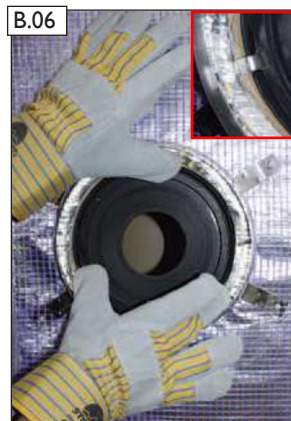
Zatlačte do otvoru adaptéra až po oceleové okraje.
