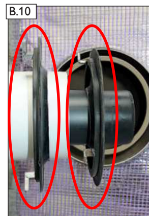
Pri inštalácii musí byť dymovod zasunutý cez obidva adaptéry.
