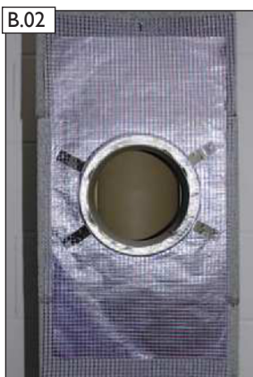
Pohľad na otvor
