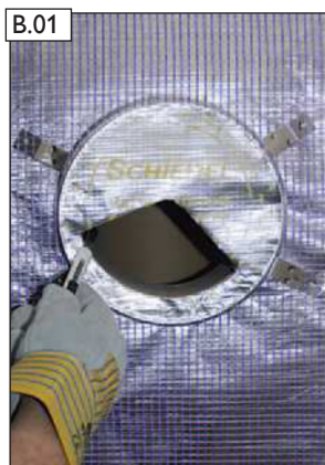
Špeciálnu hliníkovú fóliu otvorte rezacím nožom na vyznačenej línii.
