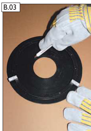
Vnútorňý otvor adaptéra vyrežte podľa požiadavky dymovodu.
