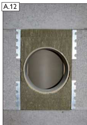
Predný pohľad na napojenie dymovodu s čelnou doskou.
